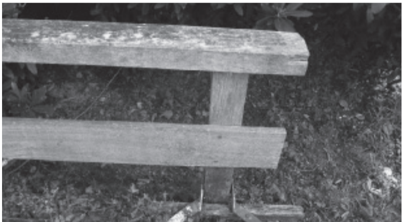
Boven: Wilhelminapark. Deze bevestiging van de leuning op de dam bij de theekoepel is verrot. De kans is groot dat wanneer er tegen geleund wordt de boel losschiet.
